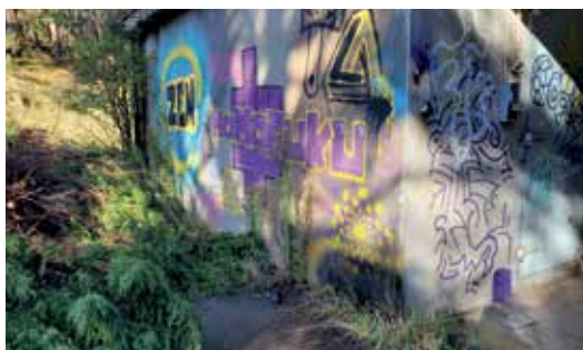
Ondergrondse bunker waar opnames kunnen plaatsvinden
