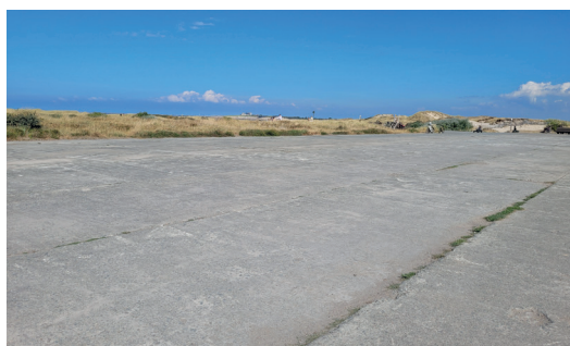
Betonzone aan het water
